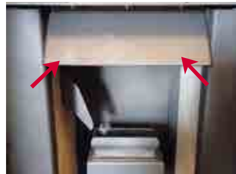
fig. 22 - Deflettore fumi pellets Bory
